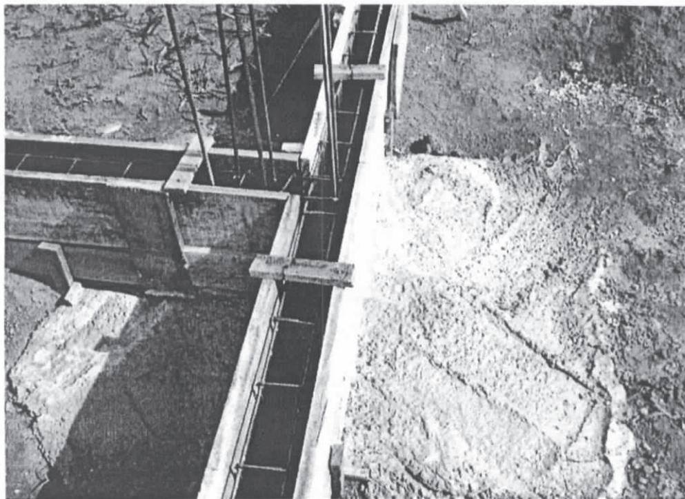
Foto 04 – Falta de estribo na armação do pilar
