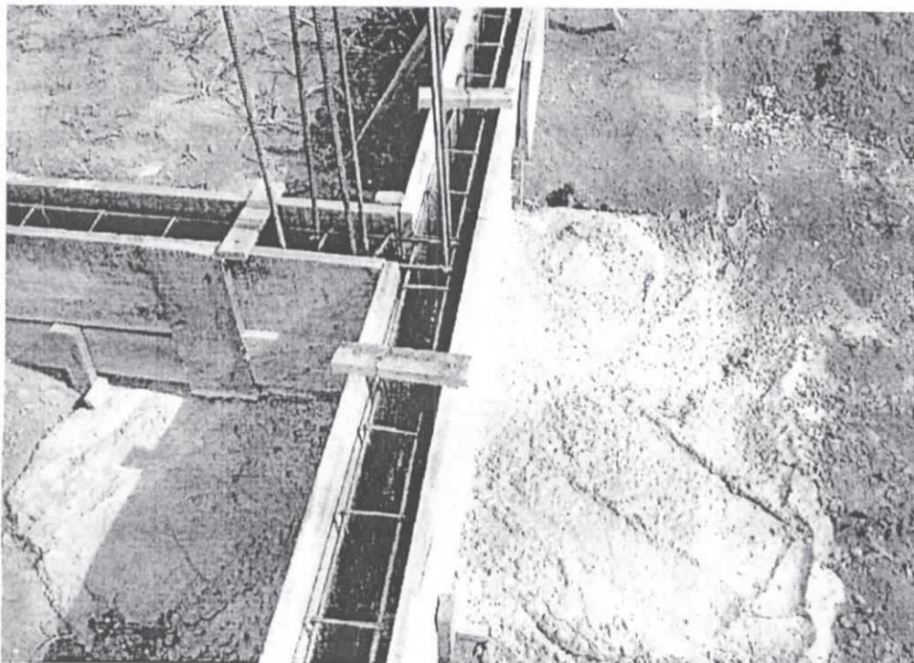
Foto 04 – Falta de estribo na armadura do pilar
